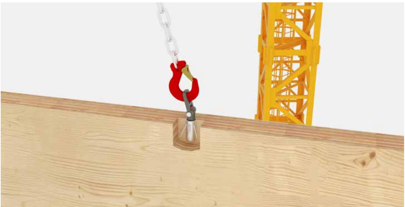
Anwendung HebeFix zum Transport einer Wand
