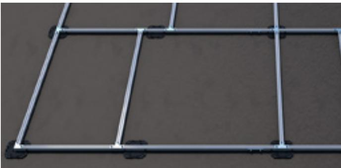
**SCHRITT 1:** Verbinden Sie die ausgelegten Montageprofile mittels Eck- und T-Verbindern. Setzen Sie zudem unter die Verbindungspunkte jeweils eine Lastverteilplatte.
