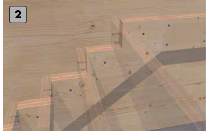
Stufenabschluss frontal an der Stufenauflage anbringen.
