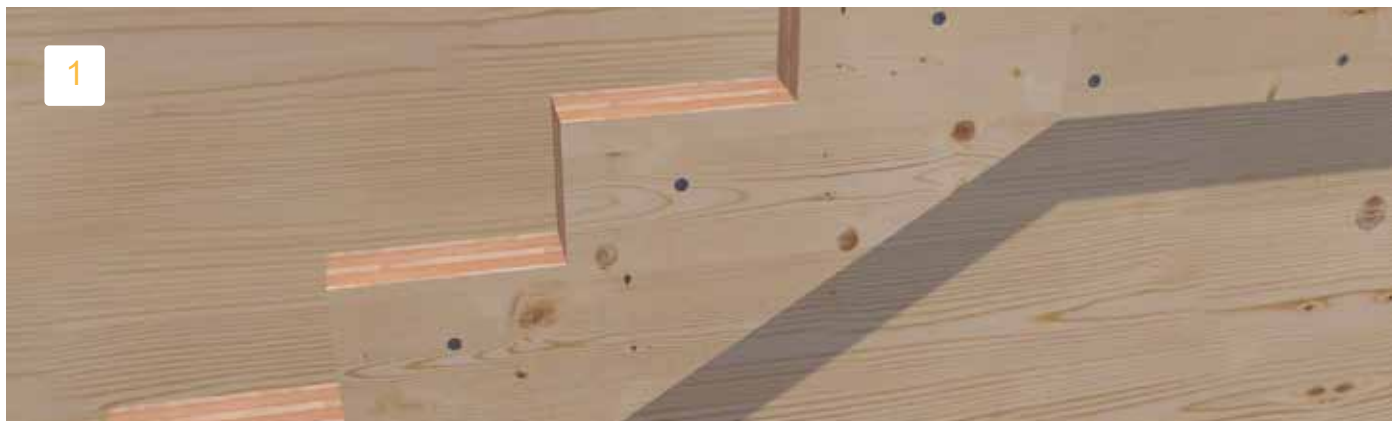
Zamontować wspornik stopni na ścianie.
