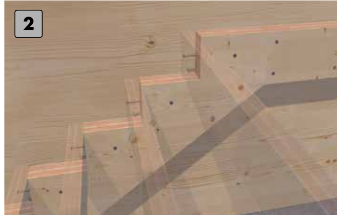
2 Stufenabschluss frontal an der Stufenauflege anbringen.
