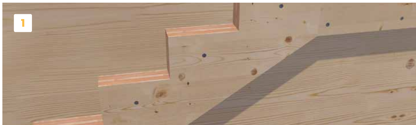
Stufenauflage an der Wand anbringen.
