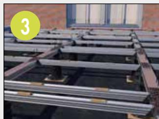
3 Distribuya los perfiles de forma pareja para proveer el apoyo óptimo para las baldosas. Ajuste con los tornillos autoperforantes Ø 4,2 x 35 suministrados.
