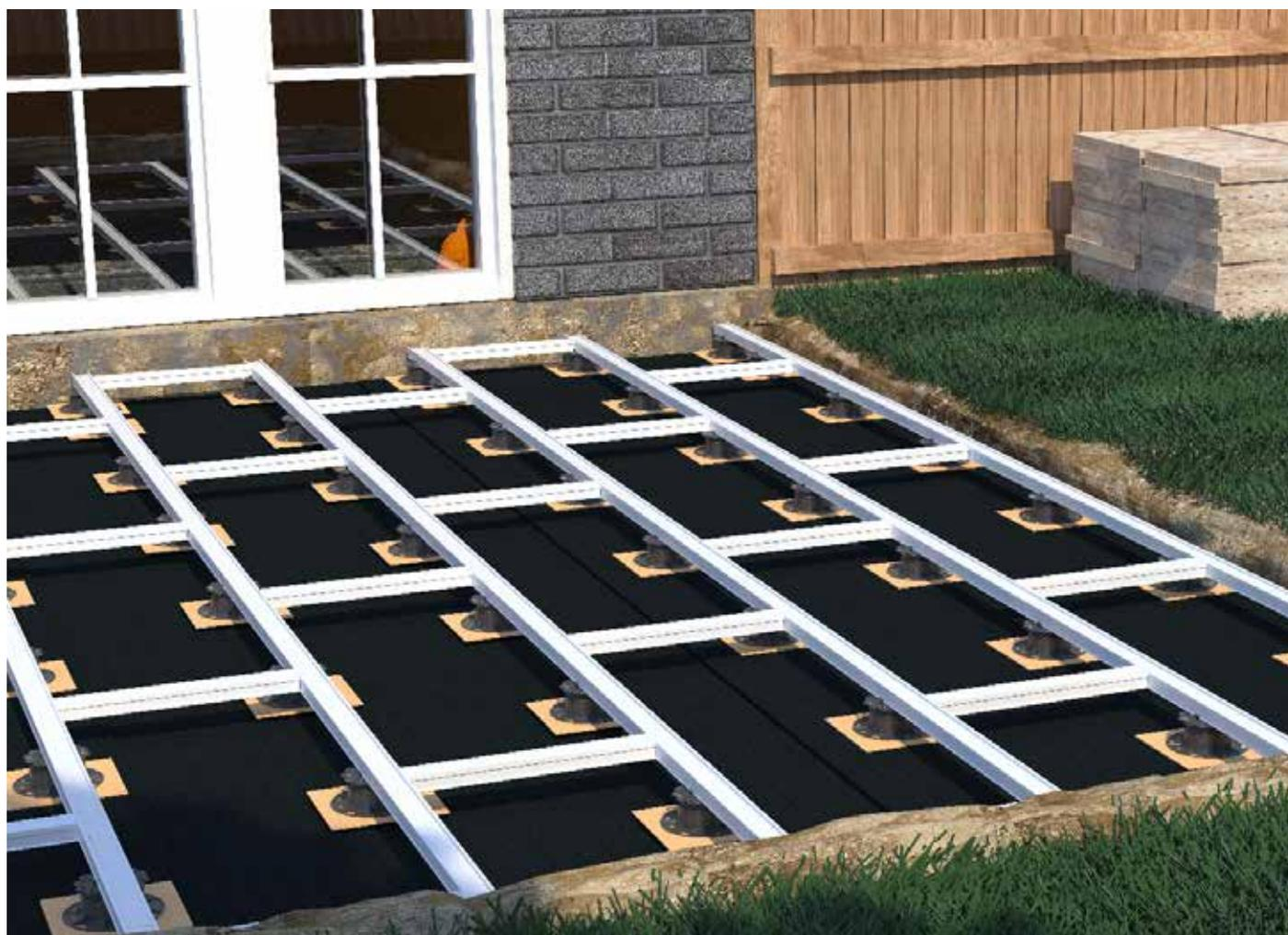
*Subestructura con plots regulables PRO, sistema de perfilería de aluminio EVO y refuerzos transversales EVO*
