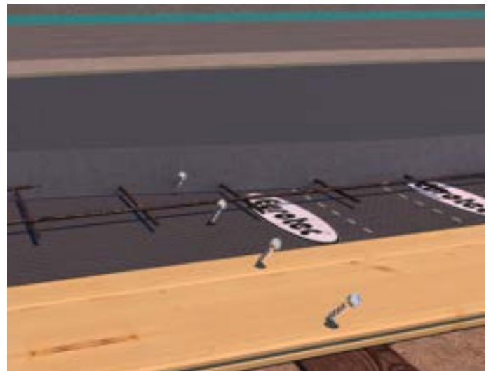
Schichtaufbau HBV-Standarddecke
