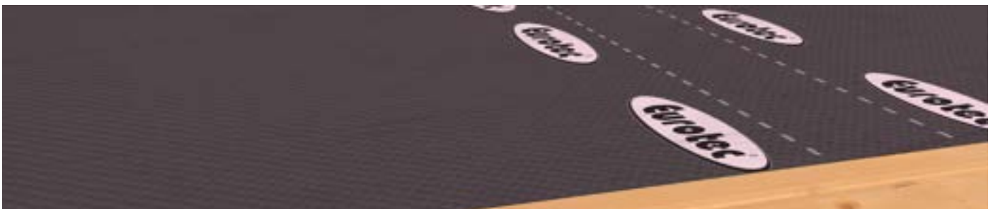
Schalung und Folie auf der Bestandsdecke
