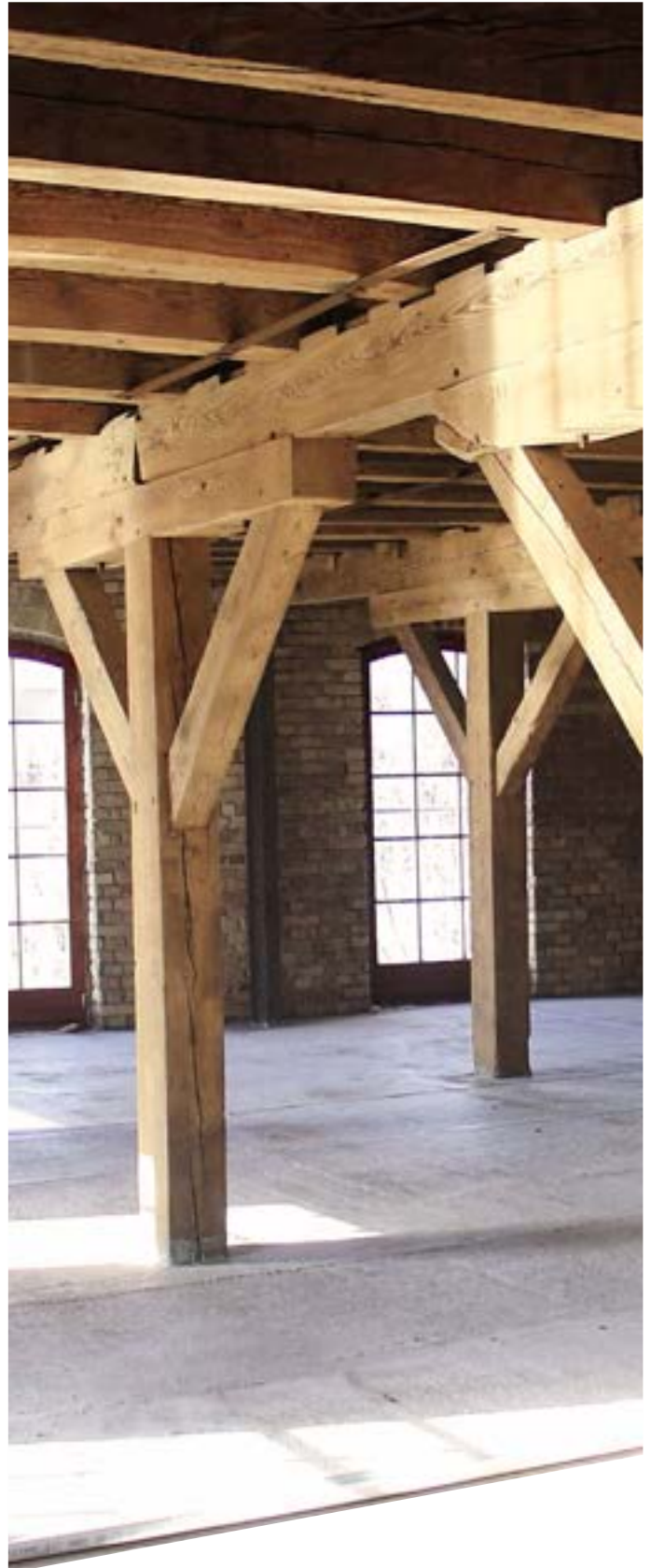
Innenansicht eines Hauses mit alter Holzbalkendecke
