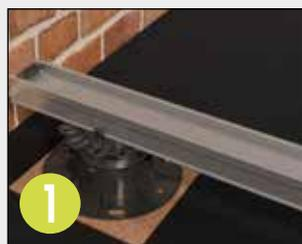
1 Fixez le composant 2 du StarterClip sur la face supérieure de la structure porteuse de la terrasse.
