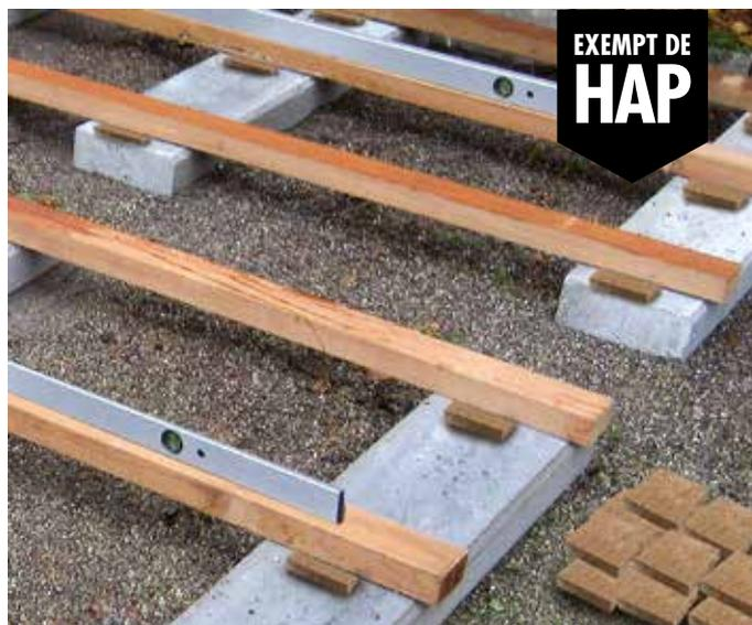
Les écarteurs Liège-Pad sont placés entre le soubassement de terrasse et la fondation/le support et forment ainsi un écart servant à la protection constructive du bois. Les écarteurs Liège-Pad sont disponibles en trois épaisseurs différentes (3, 6 et 10 mm). Les effets secondaires utiles sont, outre les avantages nommés, qu'un nivellement de hauteur du soubassement est possible grâce à l'emploi des écarteurs et que les charges sont réparties d'une manière régulière.
