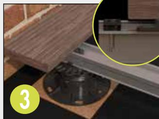
3 Insérez le composant 1 dans le composant 2. Ainsi, la lame de terrasse est fixée à la structure porteuse.
