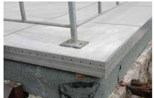
Exemple d'application profilé de finition du balcon
