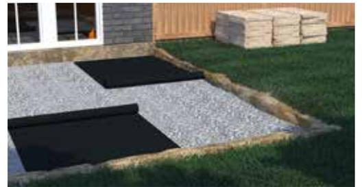
Exemple d'application couche de support en géotextil
