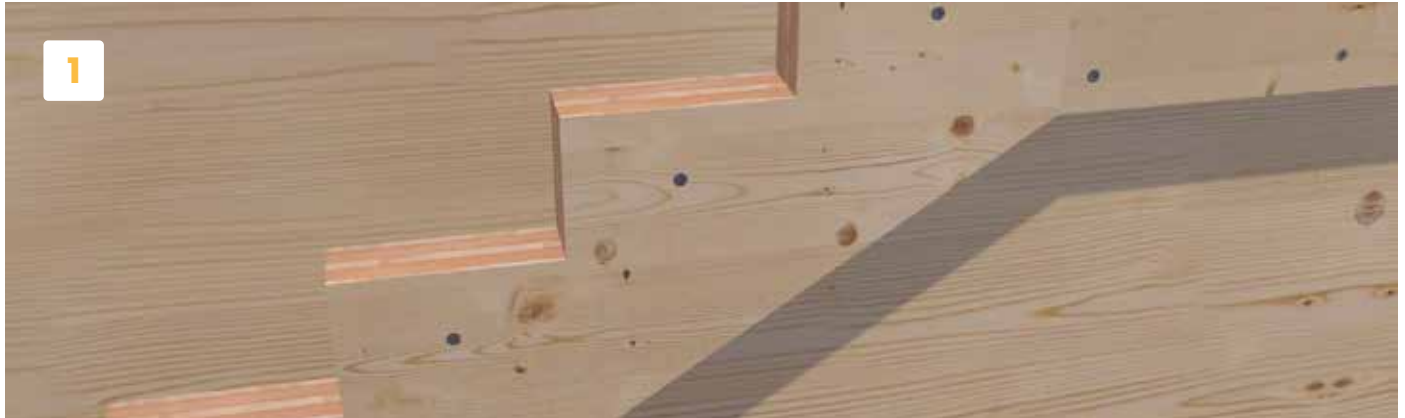
Mise en place des marches sur la paroi.
