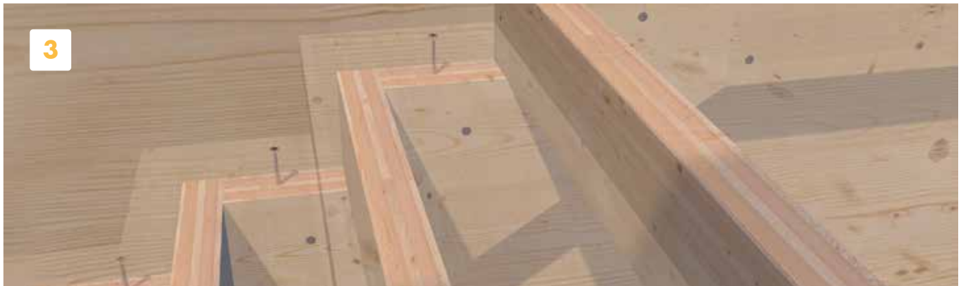
Mise en place des marches en haut du support de marches.
