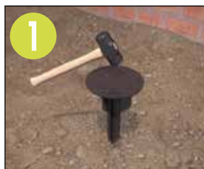
1 Wbić kotwę ziemną w grunt za pomocą młotka.
