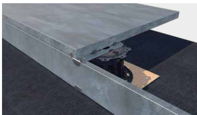
Umieszczanie płyt kamiennych w prowadnicach pojedynczego podparcia wykończenia obrzeży.
