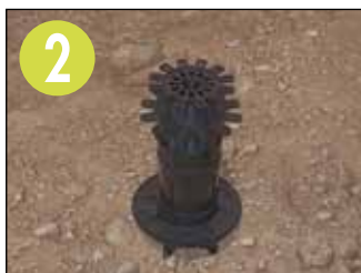
2 Po całkowitym zagłębieniu kotwy ziemnej w gruncie umieścić stopę przestawną na płycie czołowej.
