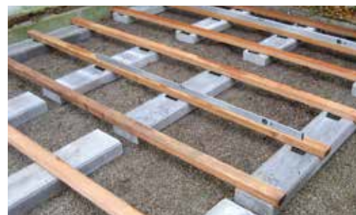
Uchwyty dystansowe Rolfi w połączeniu z drewnianą konstrukcją nośną.
