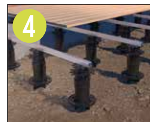
4 Kontynuować pracę jak w przypadku zwykłego montażu konstrukcji nośnej tarasu – gotowe!
