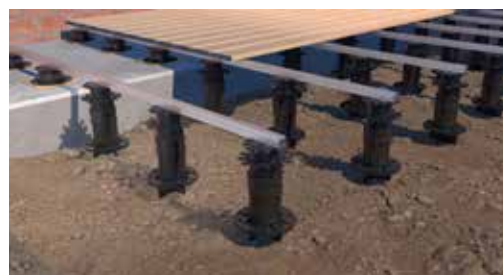
Powiększenie fundamentu tarasu za pomocą kotwy ziemnej FLEXI.
