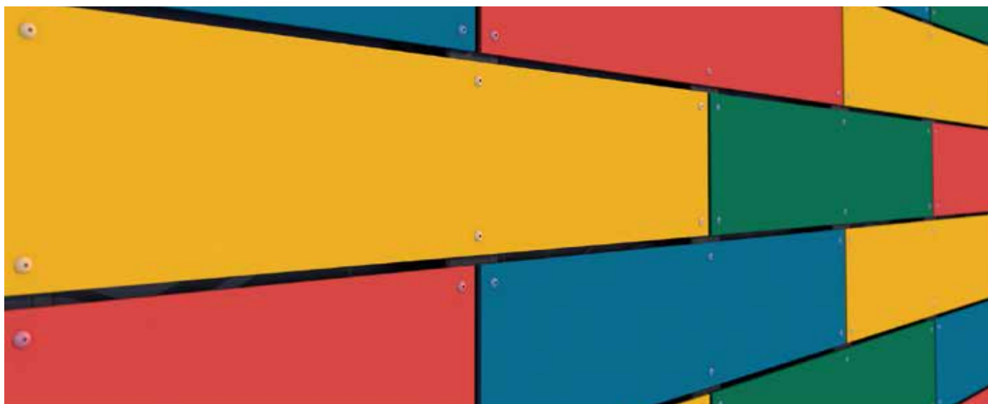
Schichtpressstoffplatten (HPL) befestigt durch Color-Fassadenschrauben in der jeweils passenden Farbe.
