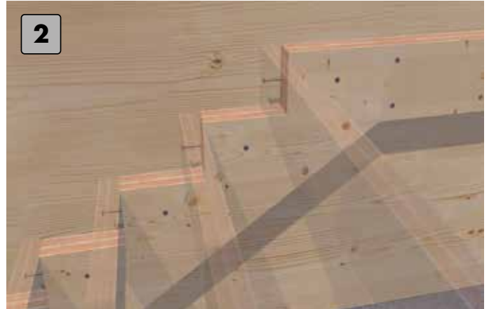
Stufenabschluss frontal an der Stufenauflage anbringen.
