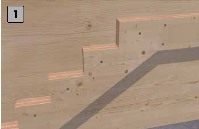
Stufenauflage an der Wand anbringen.
