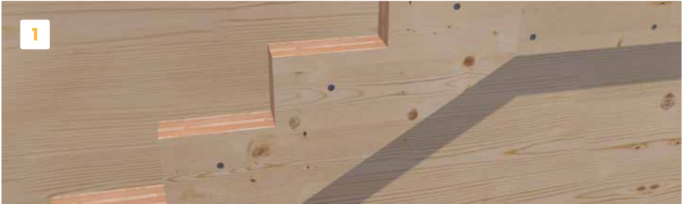
Stufenauflage an der Wand anbringen.
