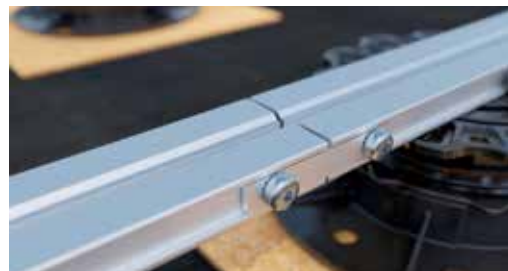
Assemblage de deux profilés à l'aide du raccord H15
