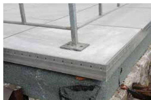
Exemple d'application profilé de finition du balcon
