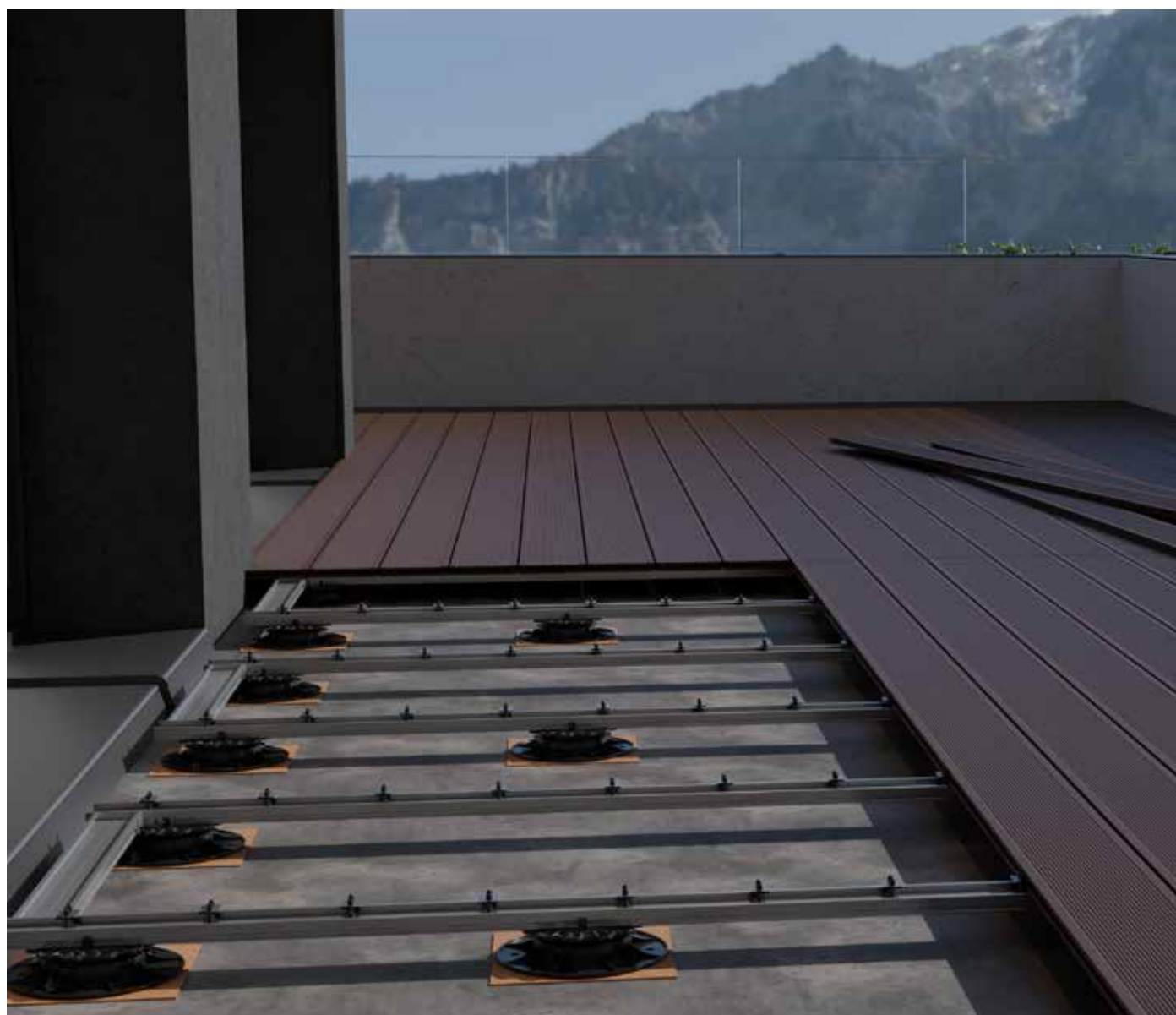
Structure porteuse avec Pieds de réglage PRO, adaptateur clic 60, profilé de système en aluminium EVO, et support de système Twin
