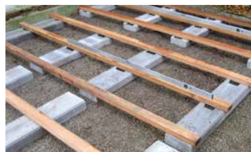
Écarteur Rolfi en combinaison avec une structure porteuse en bois.
