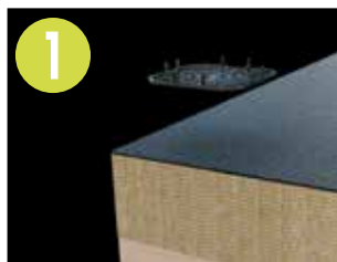
1 Placer la plaque de répartition de charges sur le support.
