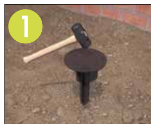
Wbić kotwę ziemną w grunt za pomocą młotka.
