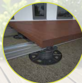
Zamocowanie widoczne przez profilowy wkręt samowiercący
