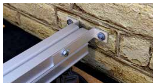
Przykład zastosowania Kątownik połączeniowy ze ścianą EVO
