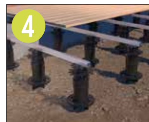
Kontynuować pracę jak w przypadku zwykłego montażu konstrukcji nośnej tarasu – gotowe!
