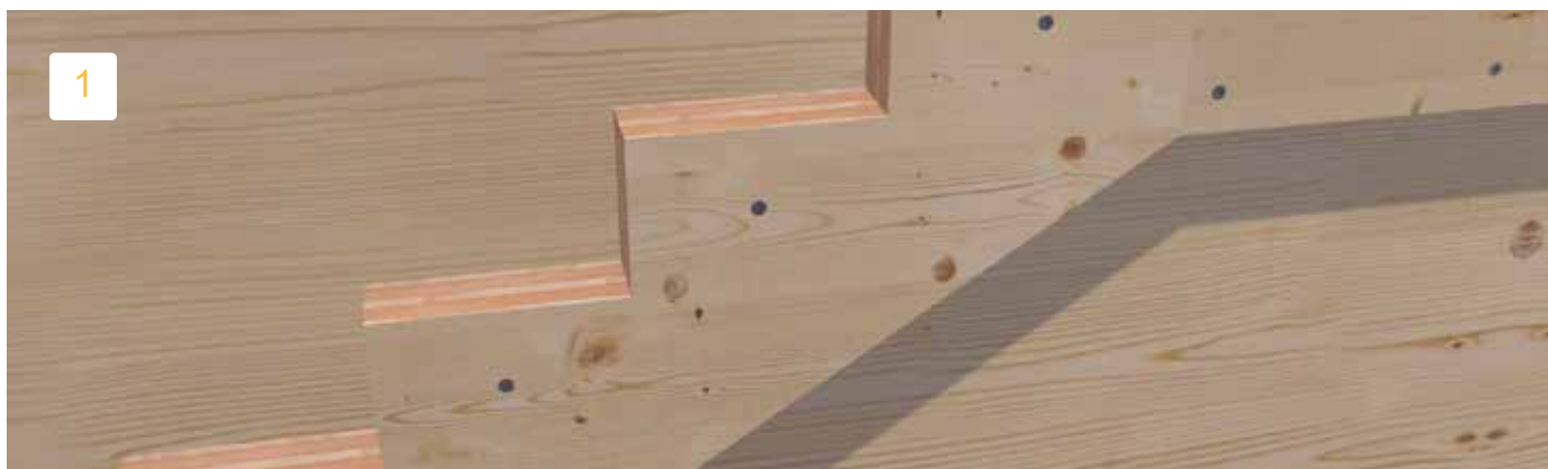
Zamontować wspornik stopni na ścianie.
