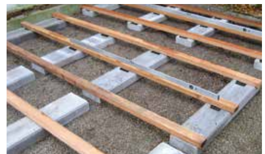
Rolfi-Abstandhalter in Kombination mit Holzunterkonstruktion.
