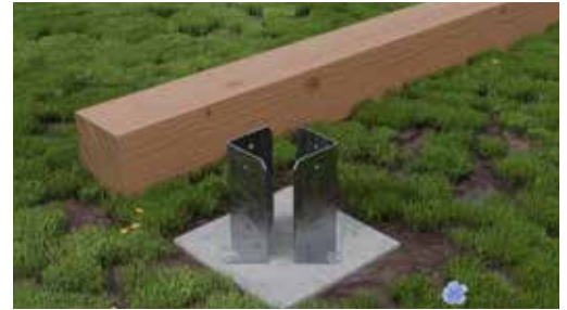
Anwendung Eckverbinder für Vierktholzpfeiler
