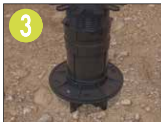
3 Mittels Thermofix- oder BiGHTY-Bohrschraube kann der Verstellfuß an der Kopfplatte befestigt werden.
