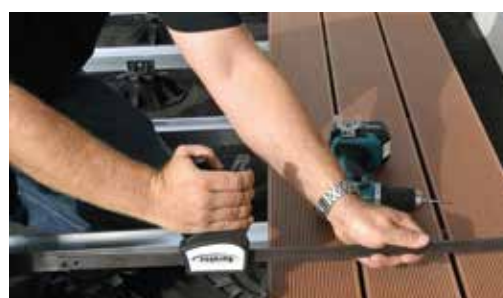
Anwendungsbeispiel Spannzwinde
