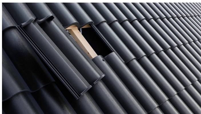
SCHRITT 2: Als nächstes wird die Dachpfanne zur Seite gelegt, um die Trag- und Konterlattung frei zu legen.
