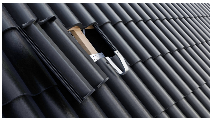
SCHRITT 5: Am Ende wird die entnommene Dachpfanne wieder eingesetzt.
