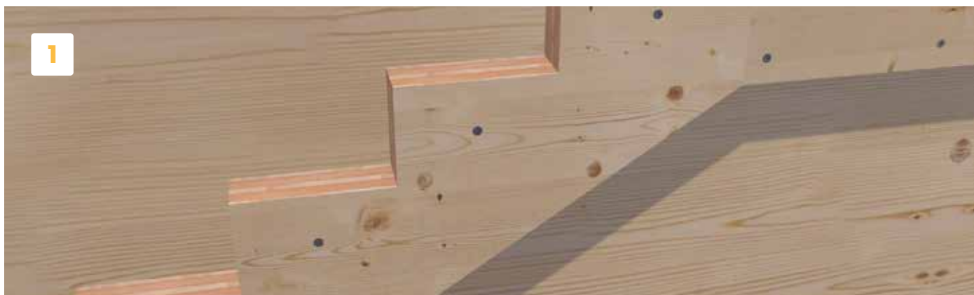
Прикрепите основание ступеней к стене
