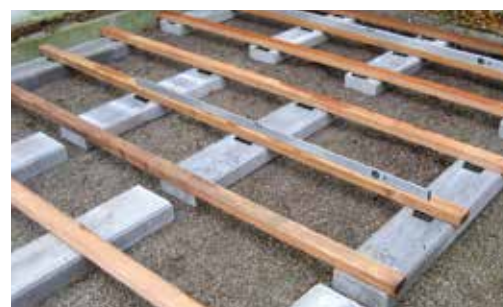
Soporte distanciador Rolfi en combinación con subestructura de madera.
