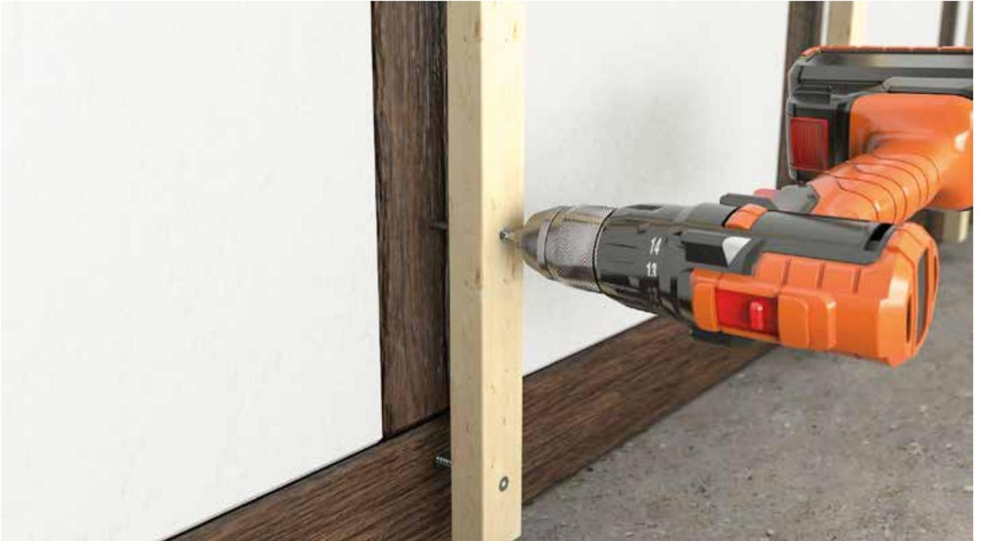
*Schnelles Ausrichten einer Unterkonstruktion mit der Justitec.*
