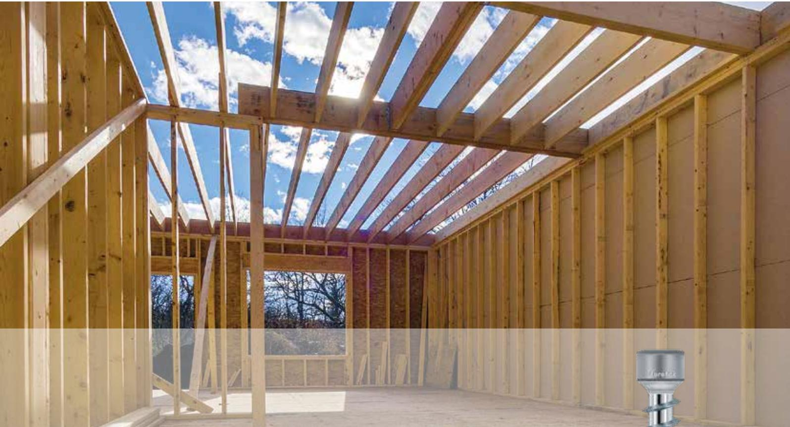
Die KonstruX ST ist als universelle Vollgewindeschraube für Verbindungen von Holzrahmenelementen wie Pfosten und Querträgern geeignet. Speziell die  $\varnothing$  6er KonstruX ST ZK ist für die Verbindung von schlanken Holzrahmenelementen in der Nutzungsklasse 1 und 2 geeignet.
