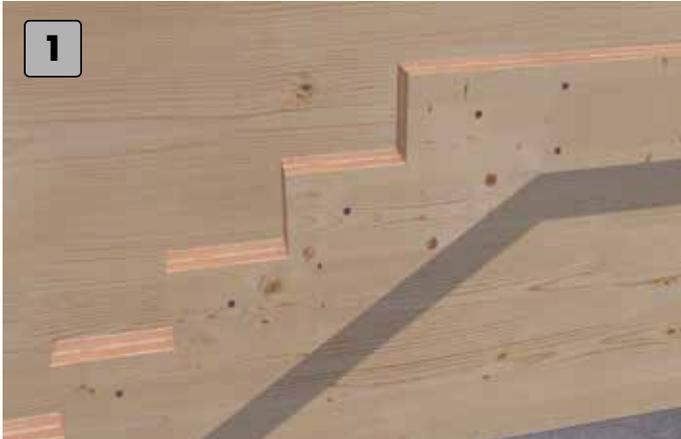
1 Stufenauflage an der Wand anbringen.
