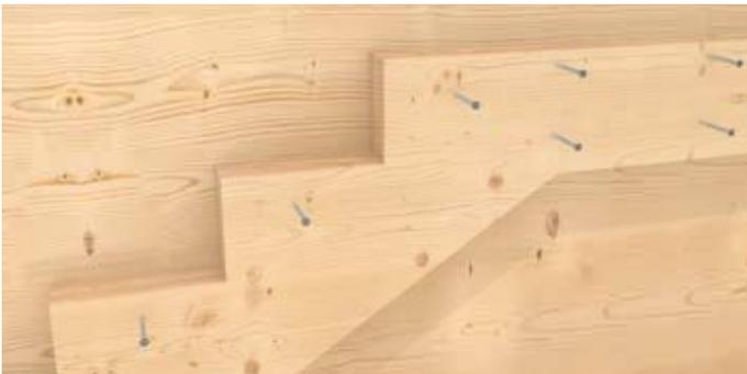
KonstruX DUO zum Bau einer Treppenunterkonstruktion
