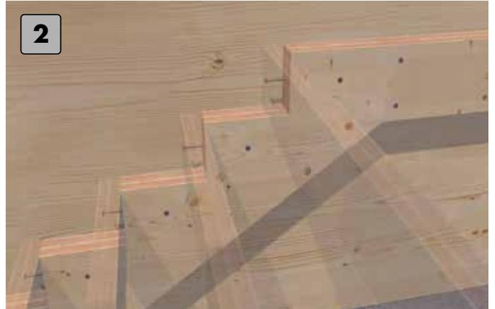
2 Stufenabschluss frontal an der Stufenauflage anbringen.
