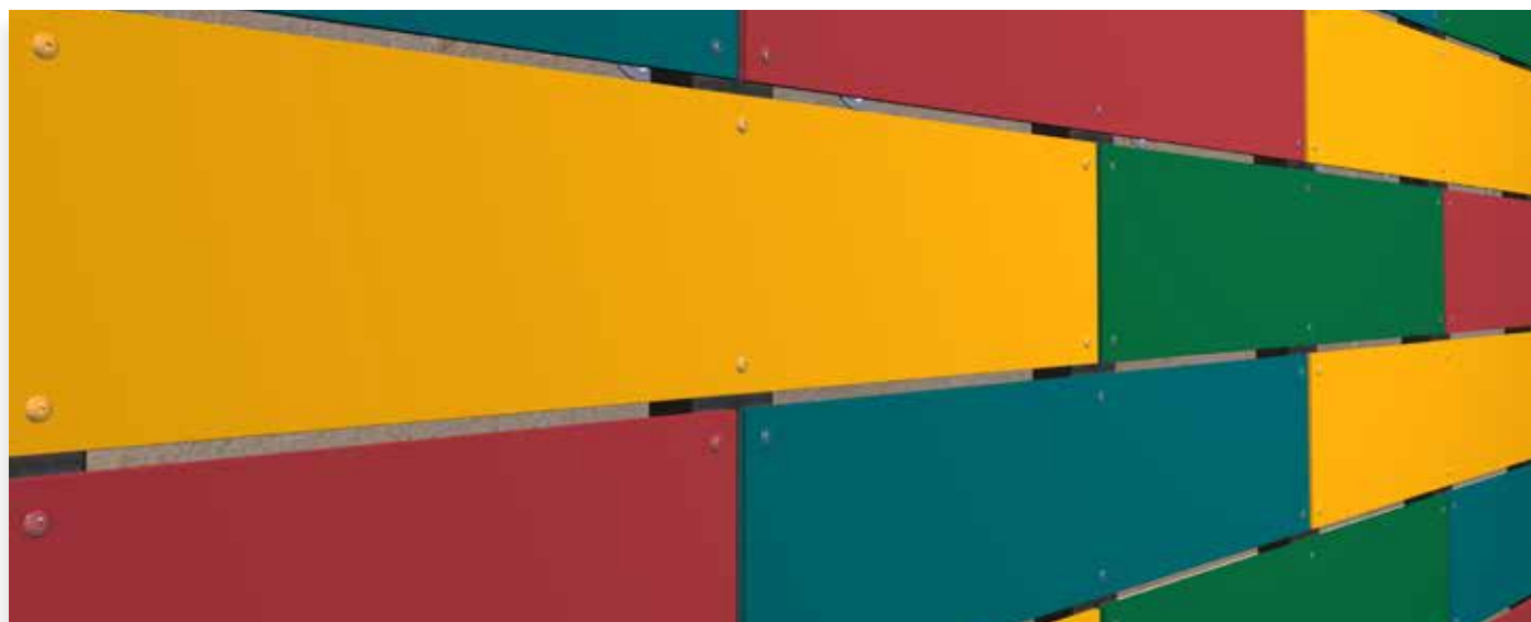
Płyty wielowarstwowe z laminatu wysokociśnieniowego (HPL) zamocowane wkrętami elewacyjnymi kolorowymi w dopasowanym kolorze.
