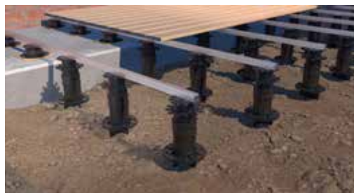
Erweiterung eines Terrassenfundaments mit dem Erdanker FLEXI.
