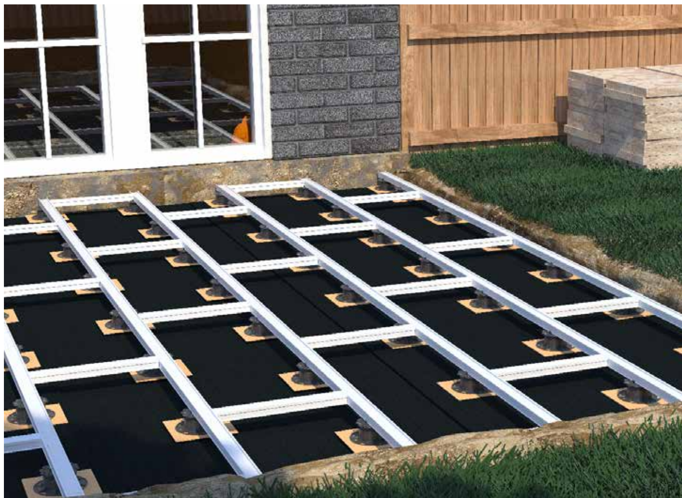
Unterkonstruktion mit Verstellfüßen PRO, Alu-Systemprofilen EVO und Queraussteifungen EVO
