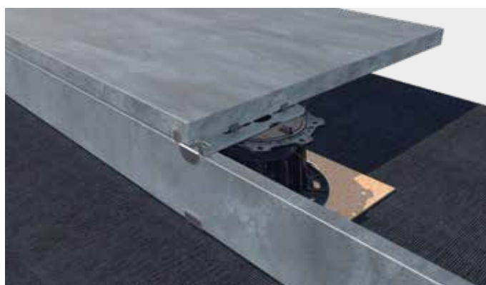
Einsetzen der Steinplatten in die Führungen der Randabschluss Einzelauflagerung.
