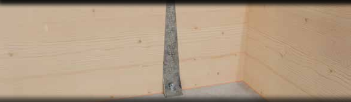
ÉQUERRES D'ANCRAGE
