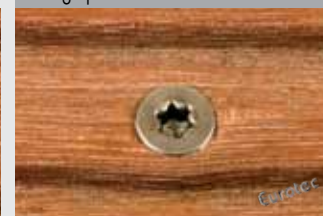
Forage préalable + vis Terrassotec
