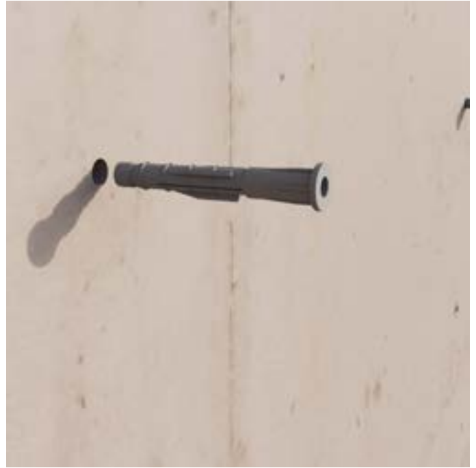
SCHRITT 2: Dübel einsetzen.
