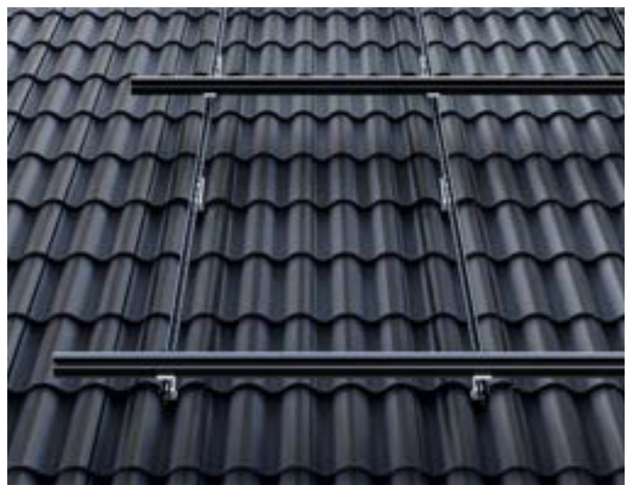
SCHRITT 14: Dieser Vorgang wird dann auf der gegenüberliegenden Seite wiederholt, um so die Fläche für die Solarmodule zu schaffen.
