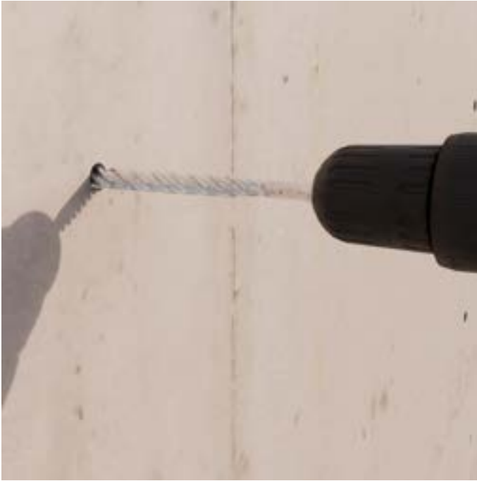
SCHRITT 1: Bohrloch für Dübel vorbereiten. 2 Bohrlöcher pro Basisprofil nötig
