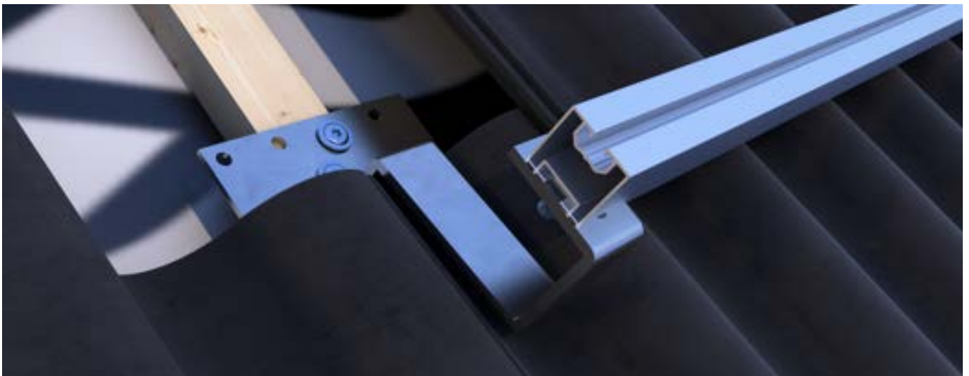
Dachhaken HEAVY an der Konterlatte montiert, durch die ausgeklinte Dachpfanne geführt und mit montiertem Montageprofil Steildach.
