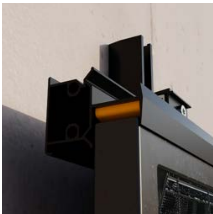
SCHRITT 12: Für den Rand brechen Sie den Stift am Abstandshalter an den Sollbruchstellen ab und klemmen diesen, wie in Schritt 17 hinter das Modul. (Die Orangene Farbe ist nur zur besseren Darstellung. Der Abstandshalter ist schwarz)
