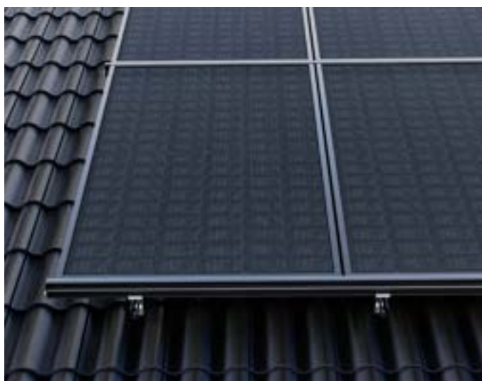
SCHRITT 21: Nachdem alle Solarmodule eingesetzt und die Endkappen montiert sind, ist das Einlegesystem LayTec vollständig aufgebaut.
