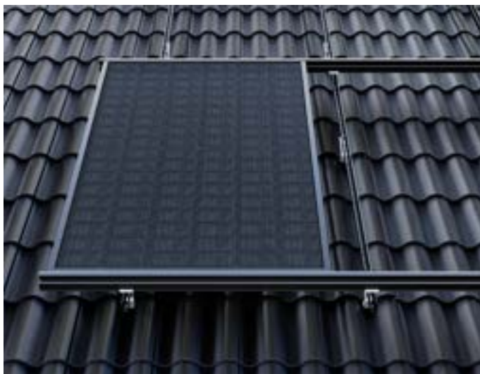
SCHRITT 16: Fertig eingesetztes Solarmodul
