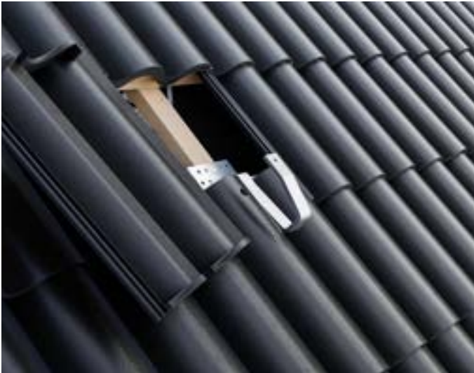
SCHRITT 3: Am Ende wird die entnommene Dachpfanne wieder eingesetzt.
