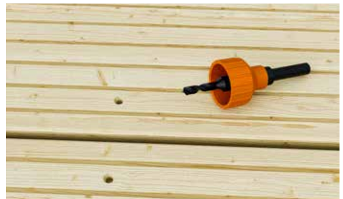
Verschraubung auf den Stegen der Nutenseite – Für eine saubere Verarbeitung empfiehlt sich das Vorbohren mit dem Versenker. Dabei ist der Geometrie des Schraubenkopfes Rechnung zu tragen.
