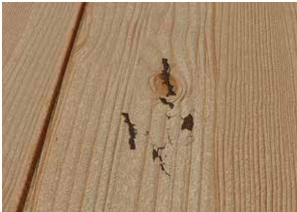
Schilfer/Ablösung der Jahrringe bei Nadelhölzern; darüber trockenheitsbedingter Riss im gesunden Ast
