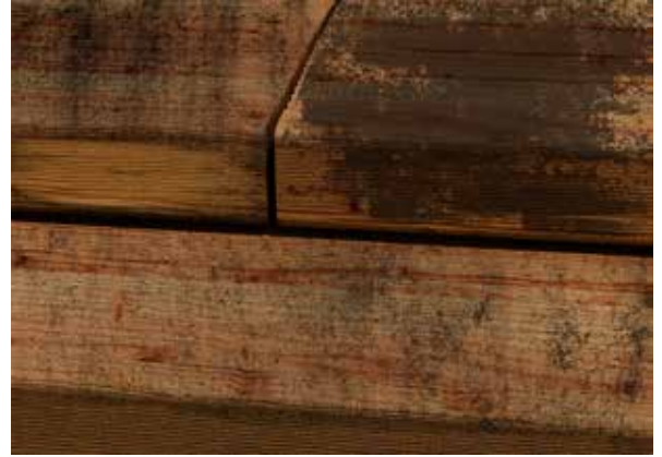
Schwarzblaue Verfärbungen durch Eisengerbstoffreaktion bei Bangkirai. Die obere rechte Bretthälfte ist mit unverdünntem fachhandelsüblichen Holzentsgrauer behandelt
