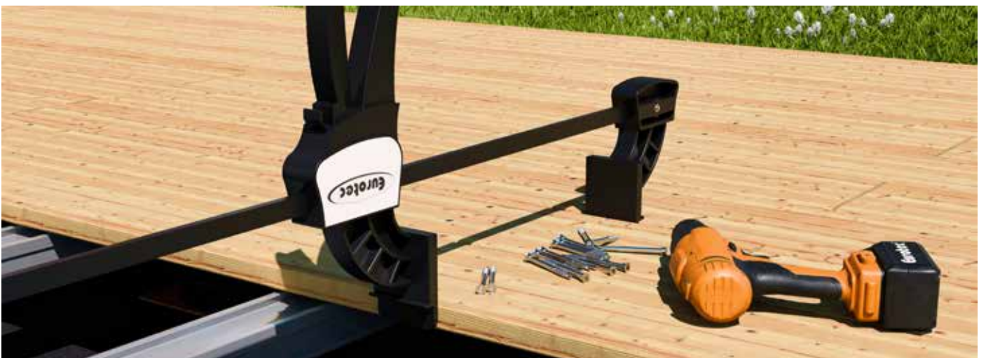
5. Montage des Terrassenbelags
